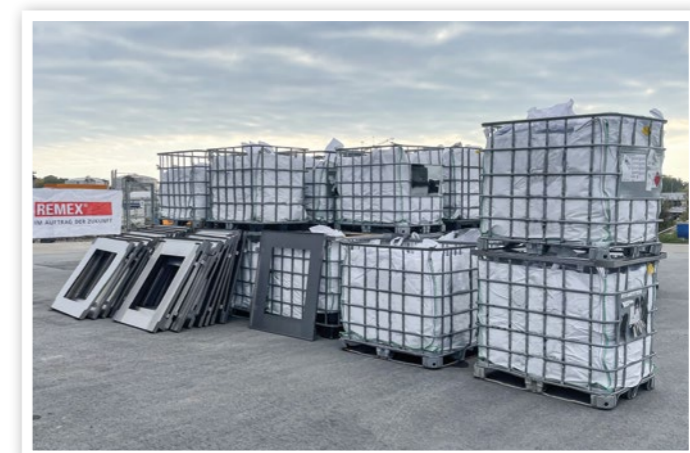
Zur Abholung bereit: die verpackten Gitterboxensysteme mit asbesthaltigen Abfällen in Zusammenarbeit mit REKS
